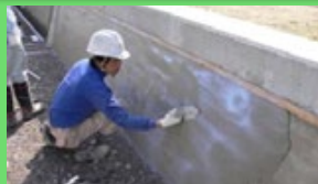
老朽化した水路壁のコーティング
