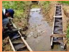
水田魚道の設置
