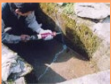
水路のひび割れ補修
