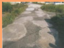
農道の窪みの補修
