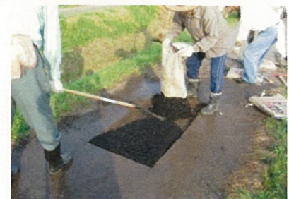
農道の補修 (対象組織が実施)
