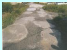
農道の窪みの補修
