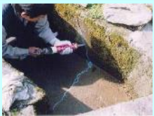
水路のひび割れ補修
