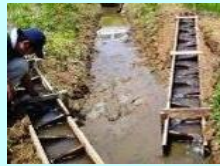
水田魚道の設置
