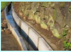
素掘り水路からコンクリート水路への更新
