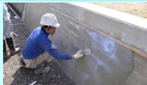
老朽化した水路壁のコーティング
