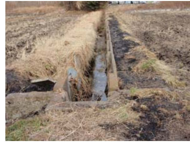
老朽化した水路（全景）
