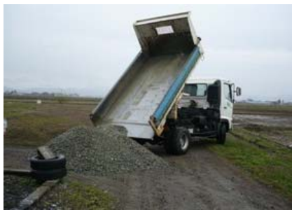
砂利の荷下ろし
