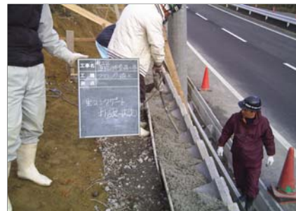
ブロック積みの施工
