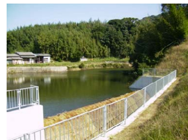
金網フェンスの設置状況
