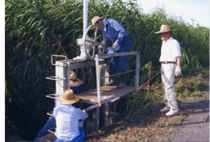
ゲートの点検
