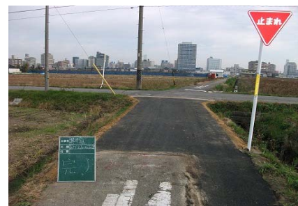
アスファルト舗装の打換え
