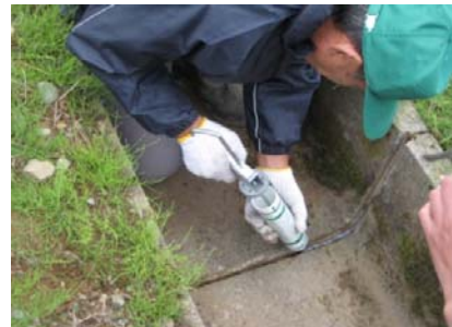
シーリング材充填
