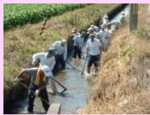
水路の泥上げ
