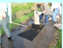
農道の部分補修
