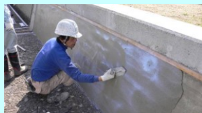
老朽化した水路壁のコーティング
