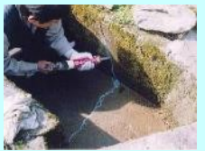
水路のひび割れ補修
