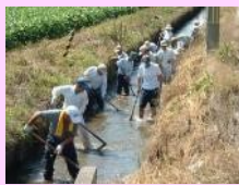
水路の泥上げ
