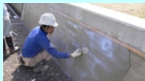
老朽化した水路壁のコーティング
