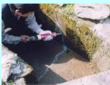
水路のひび割れ補修
