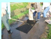
農道の部分補修
