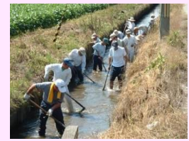
水路の泥上げ
