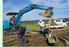
コンクリート水路の更新
