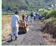
未舗装農道の舗装
