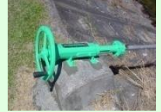
ゲート、バルブの更新
