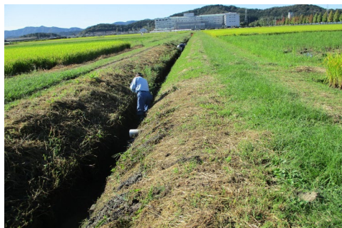
水路の泥上げ
