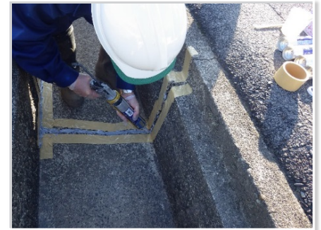
【平成28年度 小水路目地補修研修会の状況】
