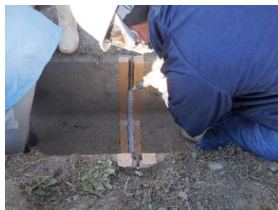
シーリング剤注入
