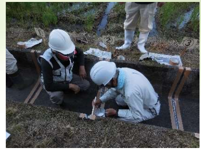
プライマー塗布
