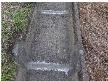
モルタル充填工法
