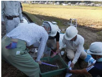
モルタル練り混ぜ
