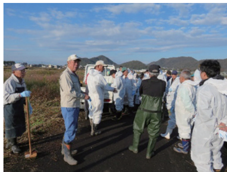
水路補修の様子
