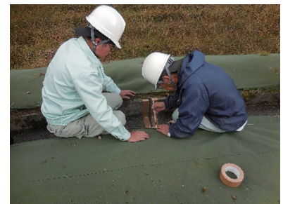
プライマーの塗布
