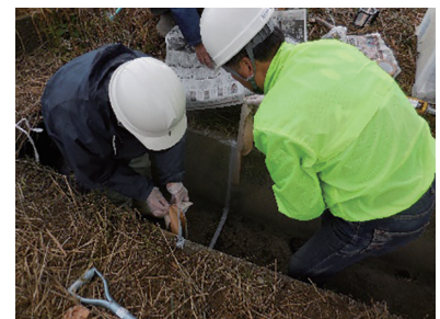
マスキング除去、完成
