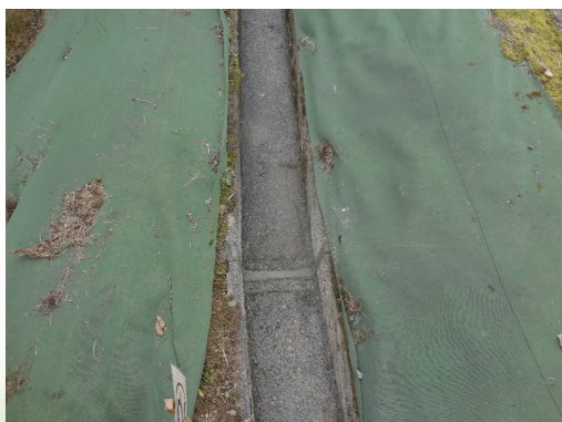
モルタル充填工法
