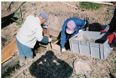
【直営施工による水路補修】
