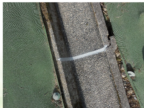
シーリング材注入工法
