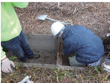
シーリング剤注入
