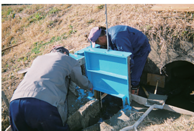
【直営施工による水路の補修工事】
