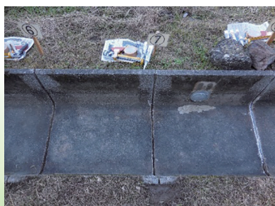
清掃後の目地
