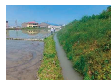
工事着手前の状況
