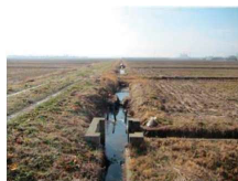
工事着手前の状況
