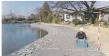
ため池堤体浸食対策工事（約1,400万円）
