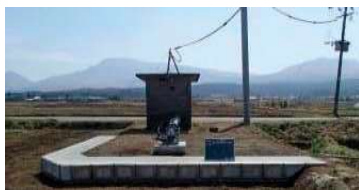
井戸更新（掘削）工事（約3,000万円）
