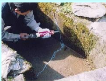
水路のひび割れ補修
