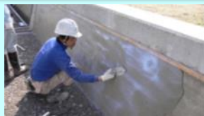
老朽化した水路壁のコーティング
