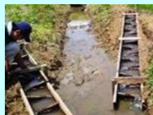
水田魚道の設置
