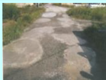
農道の窪みの補修
