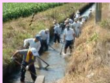
水路の泥上げ
