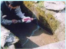
水路のひび割れ補修
