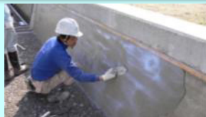
老朽化した水路壁のコーティング
