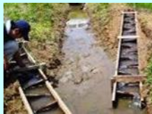
水田魚道の設置
