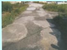
農道の窪みの補修
