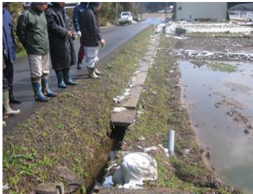
開水路の点検状況
