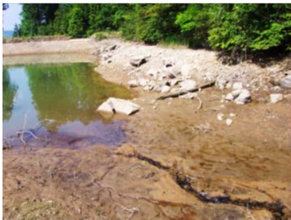
ため池に流入した土砂
