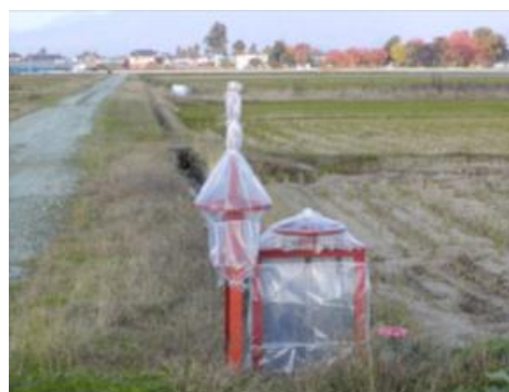
ゲートの被覆状況
