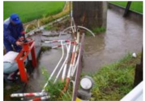
ゲートへのごみや流木の流入状況
