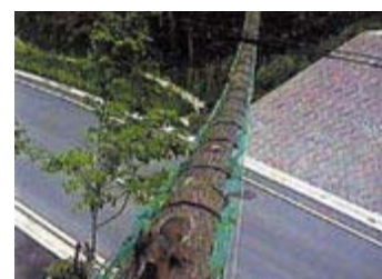
橋梁設置例 （出典：清水建設）
