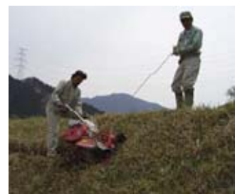
小段設置状況（掘削）
