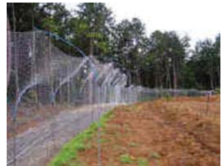
防護柵設置状況
