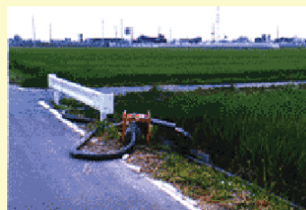
ポンプアップ状況
