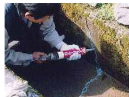
ひび割れ箇所へのシーリング材充填
