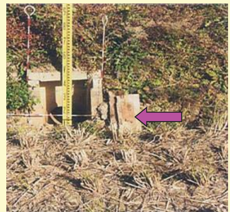
排水調整板設置状況
