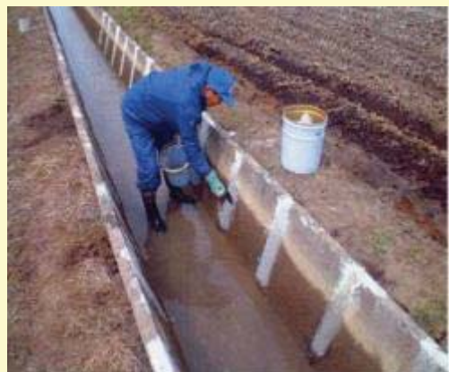
目地詰め作業
