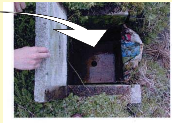
排水調整板設置状況
