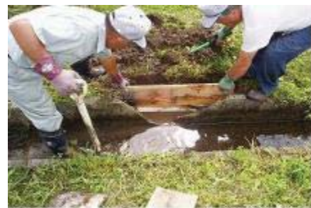
U字溝の改修作業
