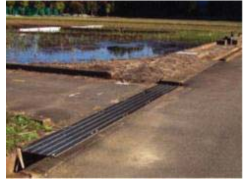
コンクリート蓋とグレーチング
