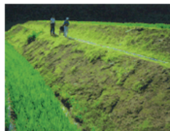
小段が設置されている法面
