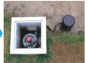
給水栓の自動化へ改良
