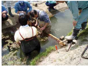
魚道の設置状況（堰板の設置）
