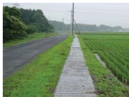
水路へのコンクリート蓋の設置
