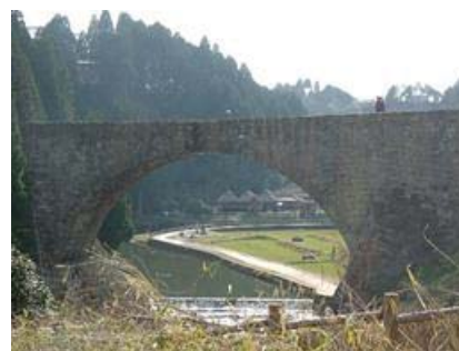
逆サイホンを利用した水路橋で国の重要文化財にも指定されている通潤橋 (熊本県山都町)
