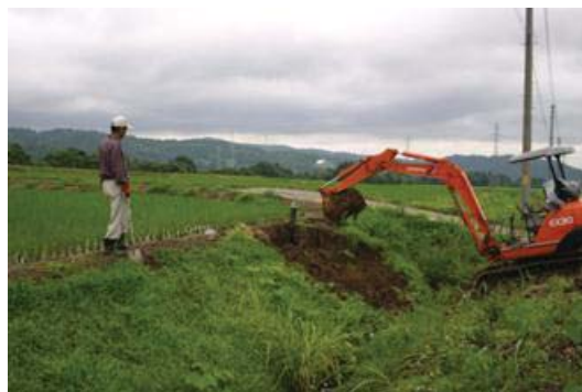
農用地法面の補修
