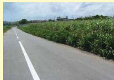
グリーンベルト設置
