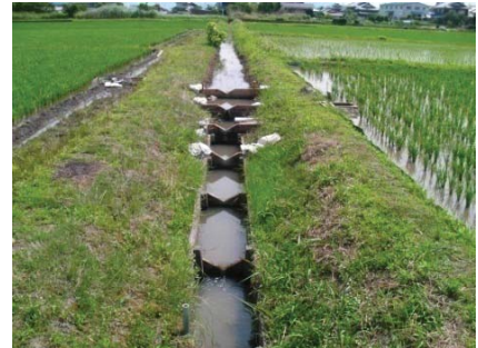
水路魚道（排水路堰上施設）
