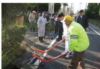
コンクリート蓋設置例
