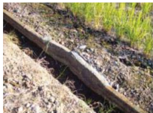
改修したU字溝
