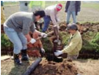
魚道の設置状況
