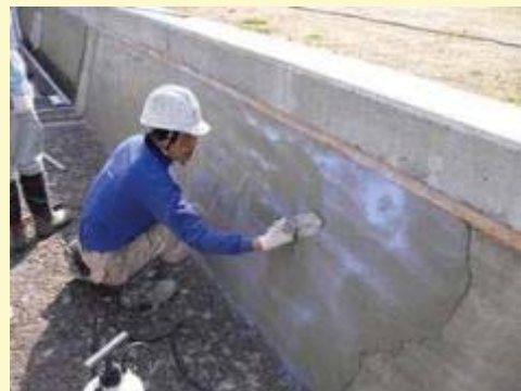
コーティング作業の状況
