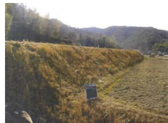
高低差のある畦畔法面
