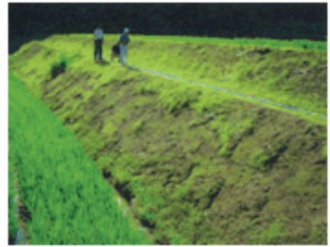
小段（犬走り）設置後の法面
