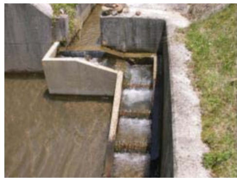
段差解消水路
