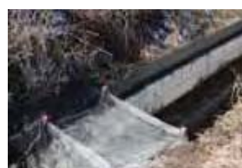
ネット設置例
