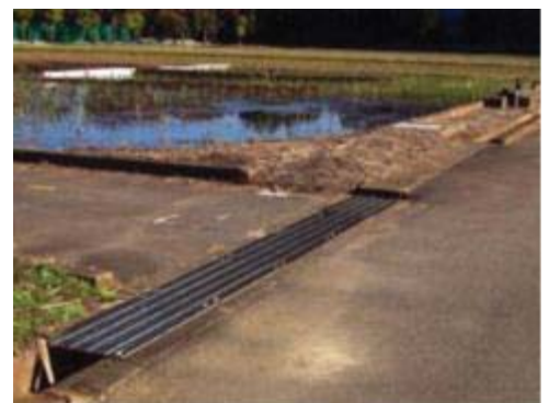
コンクリート蓋とグレーチング
