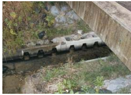
多孔コンクリート護岸
