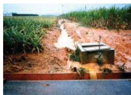
土砂の流出状況
