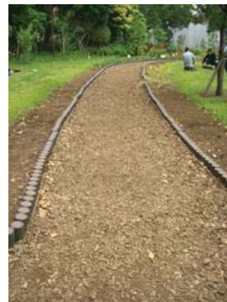
舗装材としての活用事例
