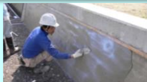
老朽化した水路壁のコーティング
