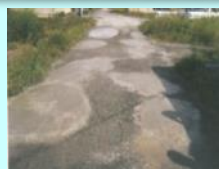
農道の窪みの補修
