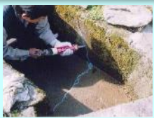
水路のひび割れ補修
