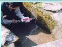
水路のひび割れ補修
