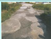
農道の窪みの補修
