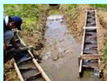
水田魚道の設置
