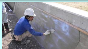
老朽化した水路壁のコーティング
