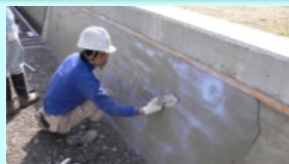
老朽化した水路壁のコーティング
