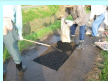
農道の部分補修
