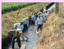
水路の泥上げ
