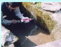
水路のひび割れ補修
