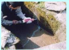
水路のひび割れ補修
