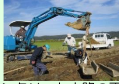
コンクリート水路の更新
