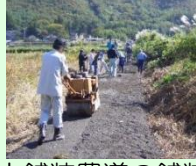
未舗装農道の舗装
