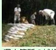
漏水箇所の補修
