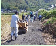
未舗装農道の舗装
