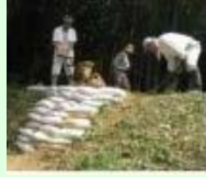
漏水箇所の補修
