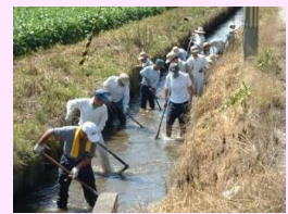
水路の泥上げ
