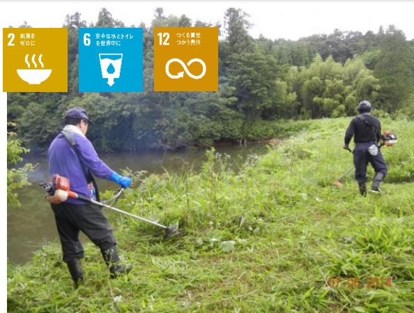
ため池堤体の草刈り
