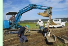
コンクリート水路の更新
