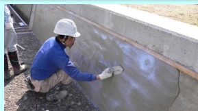
老朽化した水路壁のコーティング
