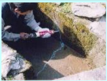
水路のひび割れ補修
