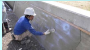
老朽化した水路壁のコーティング
