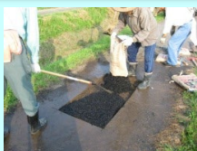
農道の部分補修
