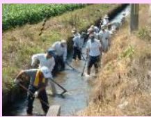
水路の泥上げ
